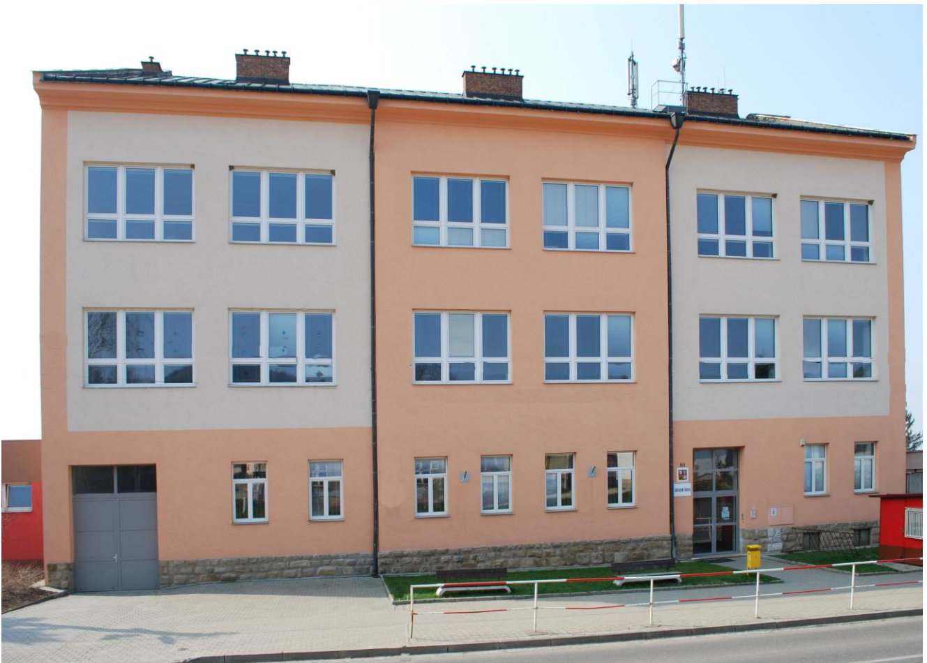
Budovy školy na Náměstí a na Masarykově ulici
