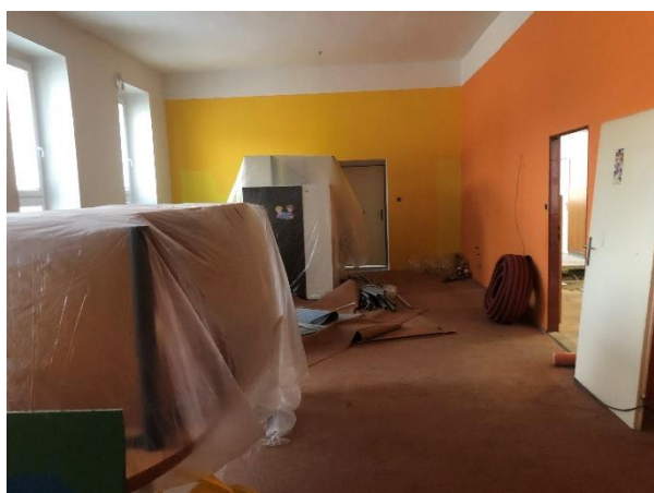
V době rekonstrukce
