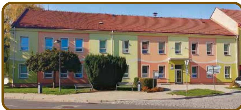
budova 1. stupně, Náměstí 106
